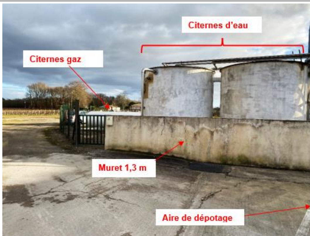
Figure 33 : Muret de protection des citernes de gaz
